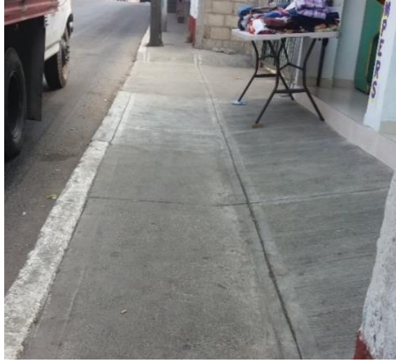
Imagen 2. 15. Banqueta en buenas condiciones. (Av. Puerto México)
