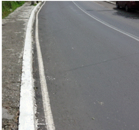
Imagen 2. 2. Carpeta asfáltica en buen estado (Av. Puerto México).
