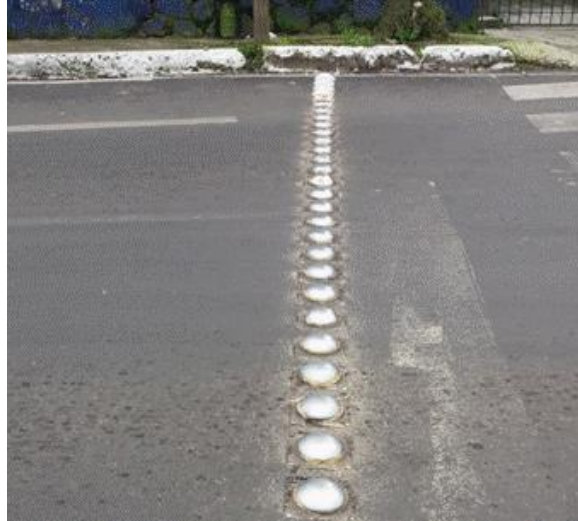
Imagen 2. 7. Botones Metálicos de tránsito en condiciones aceptables. (Calle Ocampo)
