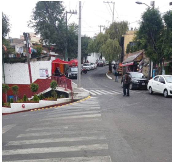
Imagen 2. 8. Balizamiento destinados al paso del transeúnte en condiciones poco visible (Av. Juárez con Av. México)
