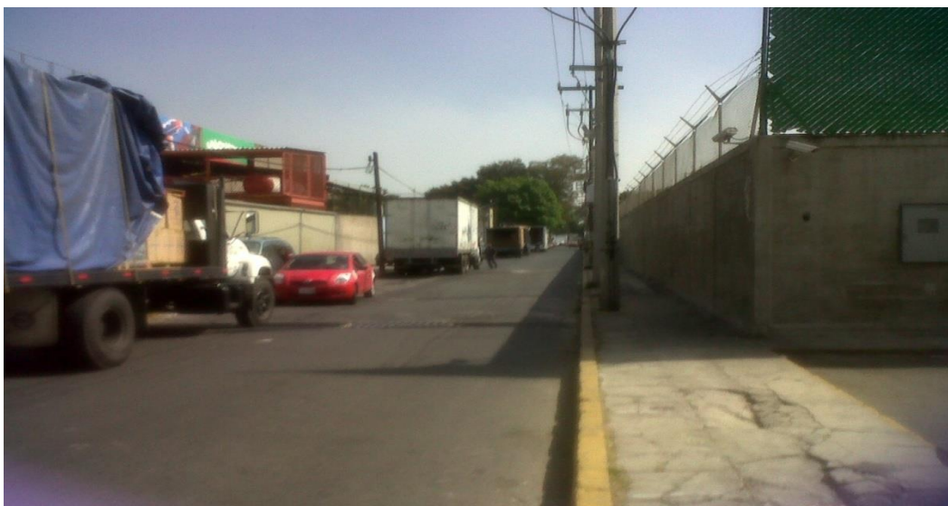
Figura 2.5.16. Calle Lebrija estacionamiento lateral, [8]
