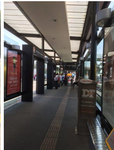
Figura 3.50 Estación San Lázaro 01:52 p.m.
