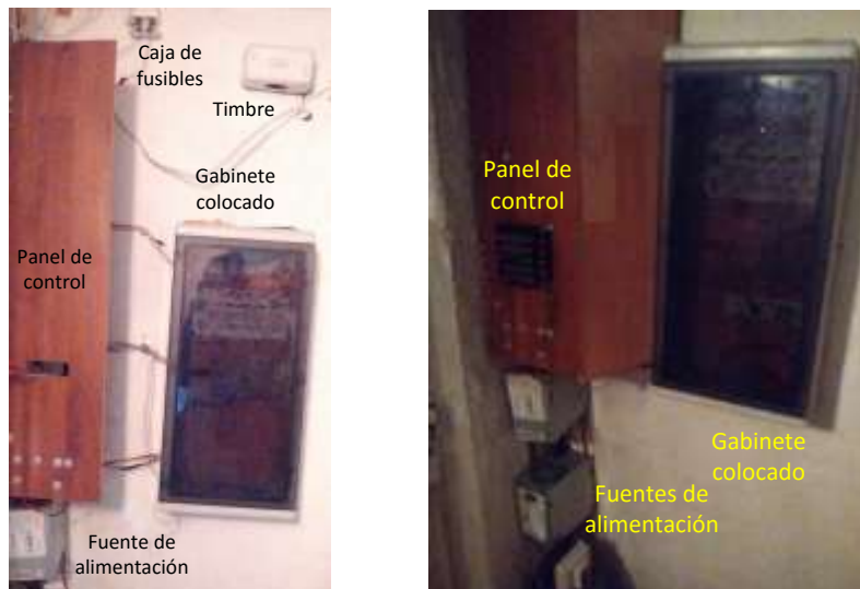
Figura 30. Colocación del gabinete y fuentes
