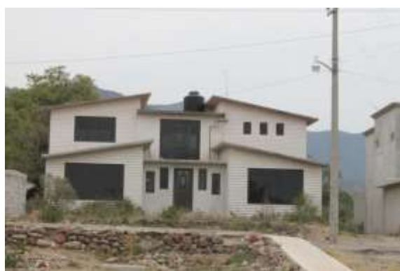
Casa construida y deshabitada en El Tablón propiedad de un migrante.
