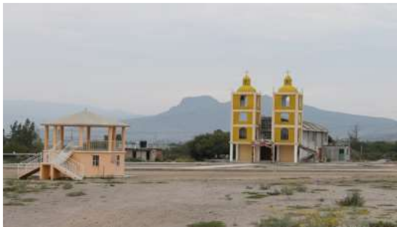
Iglesia y quiosco del centro de la comunidad el Tablón.
