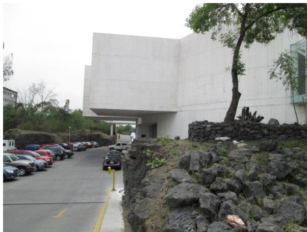
Entrada del personal y oficinas por la parte posterior del museo Autoría propia.
