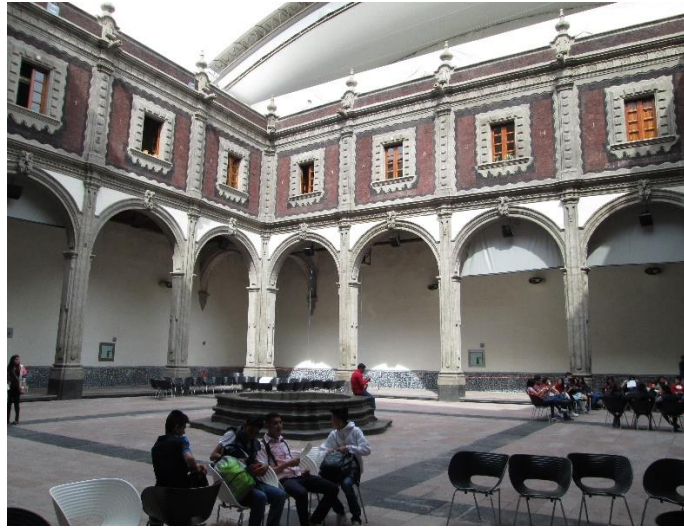
Patio principal del edificio. Autoría propia.
