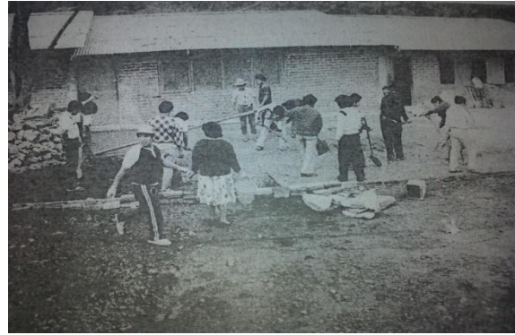
Foto 2: construcción de la primaria
