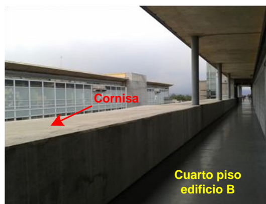
Figura 4.5 Cuarto piso del edificio B. UACM
