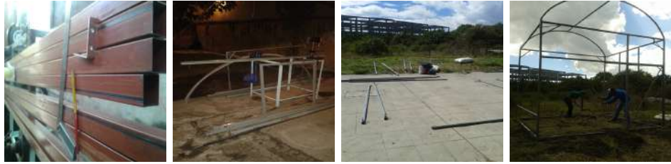
(a) Materiales (b) Cortado y pin-tado (c) Armado del in-vernadero. (d) Estructura completa
