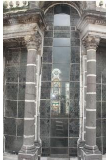
Fig. 26d. Grieta en cúpula
