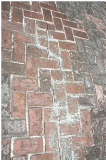
Fig. 26c. Grieta en bóveda
