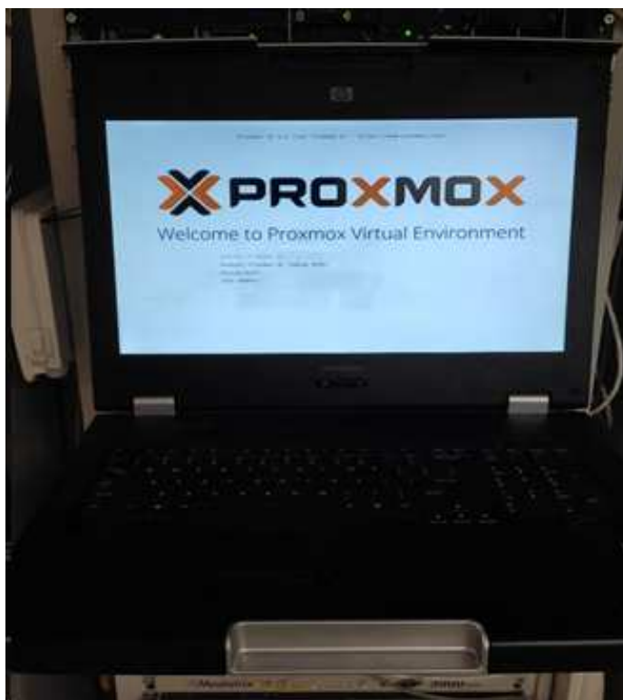
Figura 3.4: Instalación de Proxmox en el primer servidor físico.
