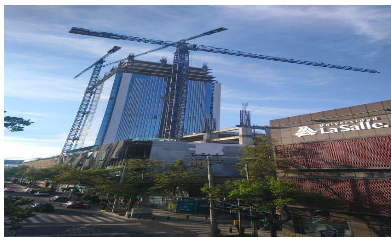
Fotografía propia: Construcción Espacio Condesa. Cuauhtémoc, Ciudad de México, México.
