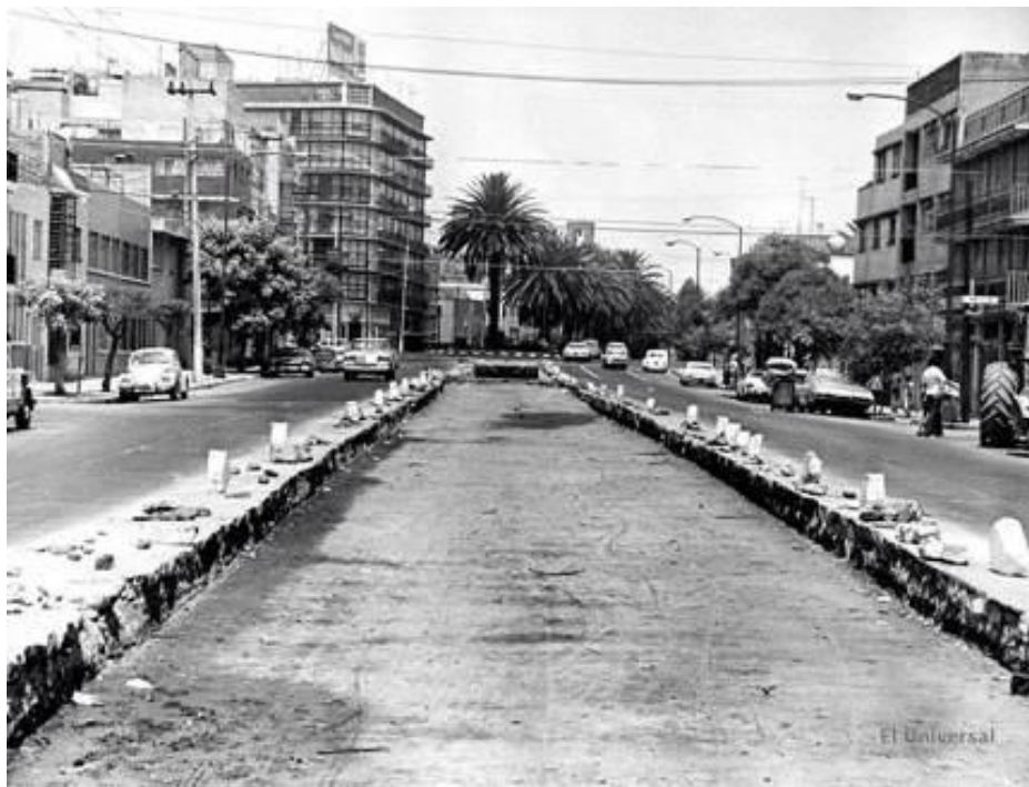
Figura 7. Trabajos de construcción en los Ejes Viales de la Ciudad de México (1978).
