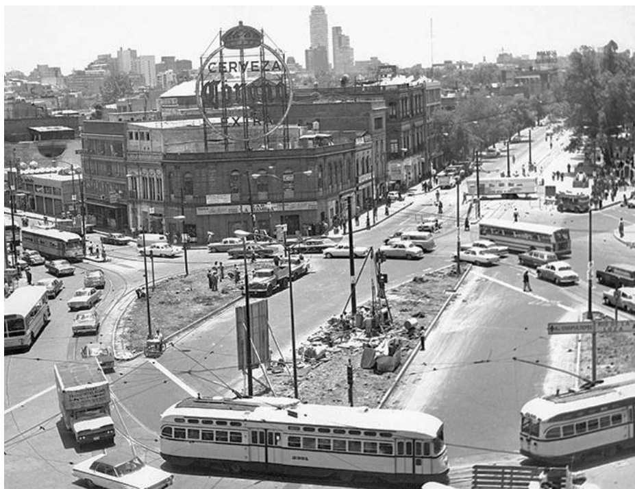
Figura 6. Primeros trabajos de construcción de la Línea 1 del STC Metro, en la Glorieta de las Avenidas Bucareli y Chapultepec.
