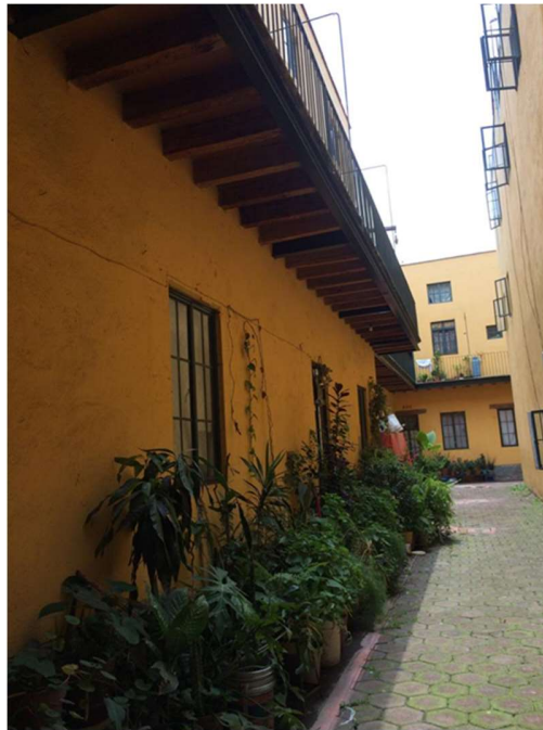
Figura 3. Patio/Pasillo de la vecindad No.26, 2019.
