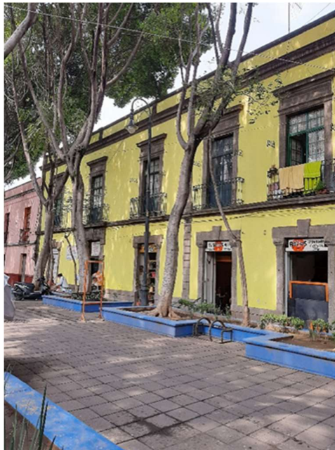
Figura 11. Mariana Rodríguez del Toro de Lazarín No.26 Fachada, 2019
