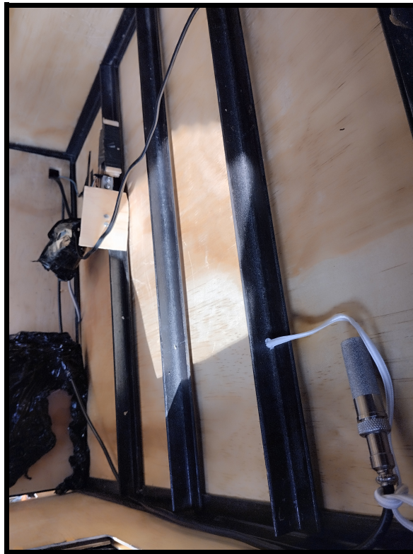
Figura 40. Instalación del sensor SHT20
