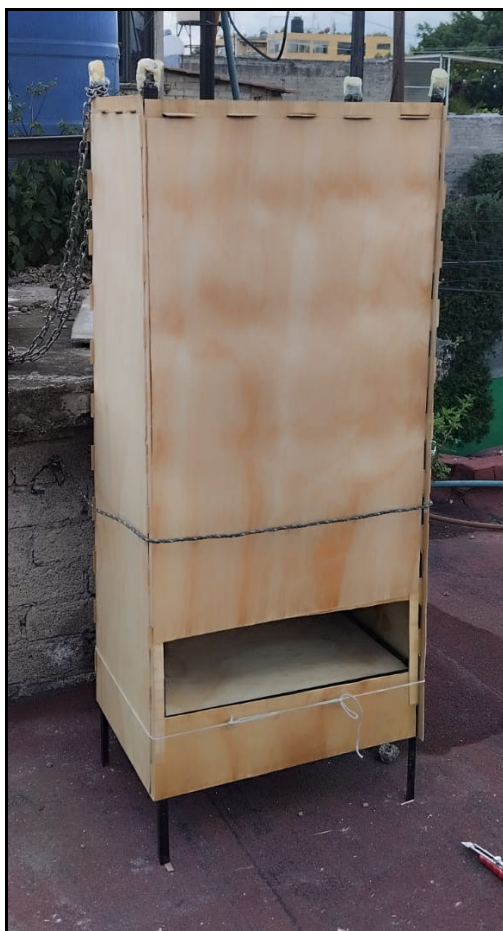
Figura 14. Colocación de laminas de triplay en deshidratador solar
