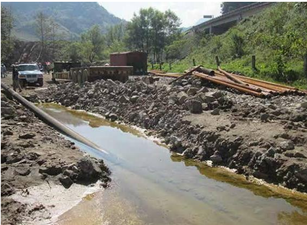
15. Pérez, D. (2014). En la imagen podemos observar como los tubos fueron colocados sobre el Río Uatsaktitla [Fotografía]. Cuacuila Huauchinango, Puebla.
