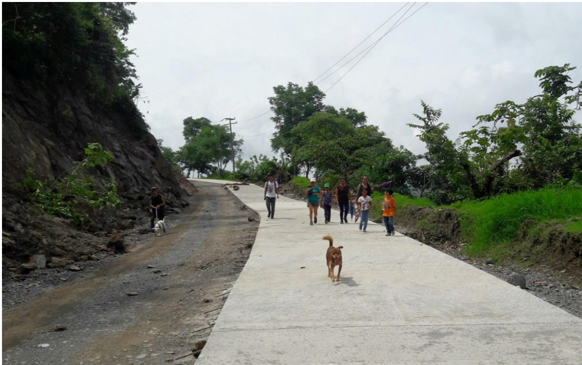
Figura 3 Pavimentación de la carretera de Acuatla
