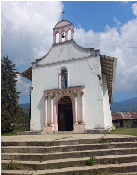
Capilla de San Isidro Labrador ubicada en la colonia Independencia. Foto tomada en noviembre de 2022.
