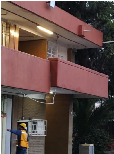
Figura A.1.25. Pasillo planta alta del edificio F.
