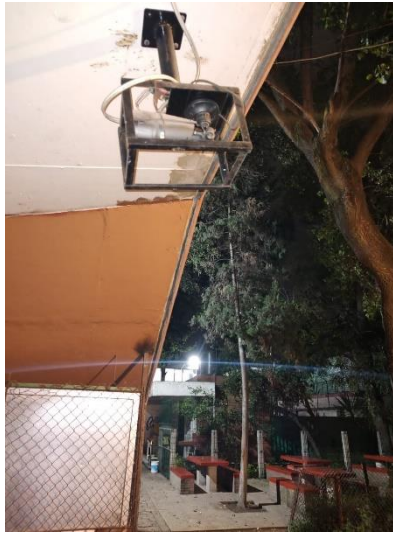
Figura A.1.14. Parte de bancas del Patio Central del edificio C.
