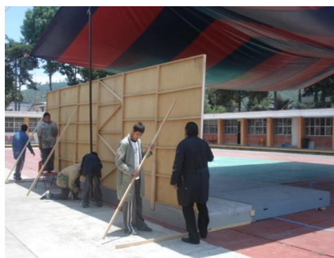
Foto. 25. Colocación de mamparas
