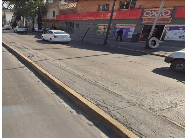
Figura 24.Servicio ruta 200 Cto interior. Fuente: Elaboración propia.
