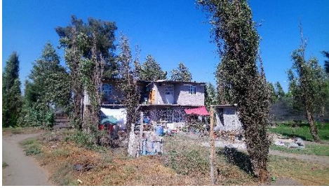
Foto: Casa construida en medio del chinamperío por residentes del lugar y habitada por ellos, en el paraje Atenco. 10-03-22
