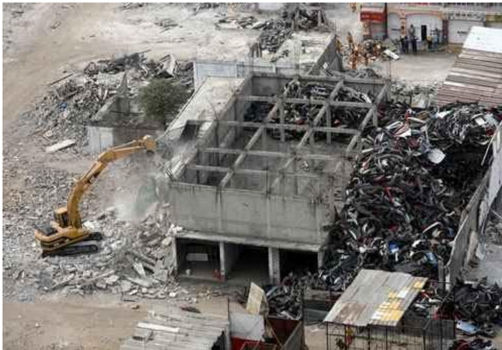
Imagen 7. Inicio de la construcción del Centro de Desarrollo Comunitario en el predio “La Ford”.
