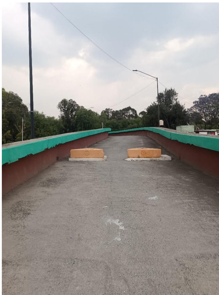
Imagen 44. Puente de la Unidad Habitacional El Rosario – Azcapotzalco-Tlalnepantla
