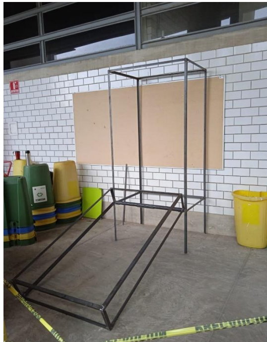
Ilustración 30: Elaboración del esqueleto mediante Angulo de aluminio. Elaboración propia.
