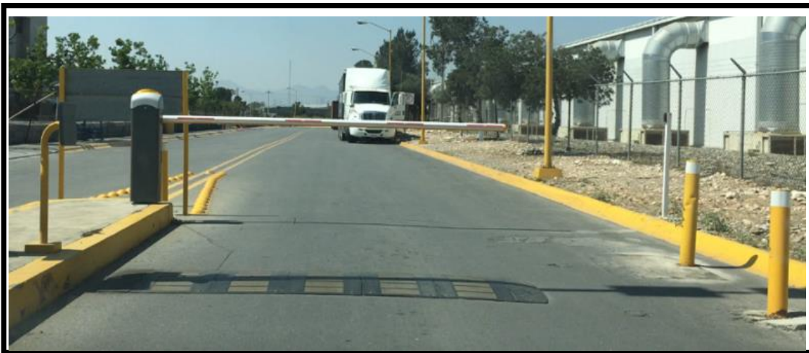
Figura 25. Instalación de la barrera vehicular
