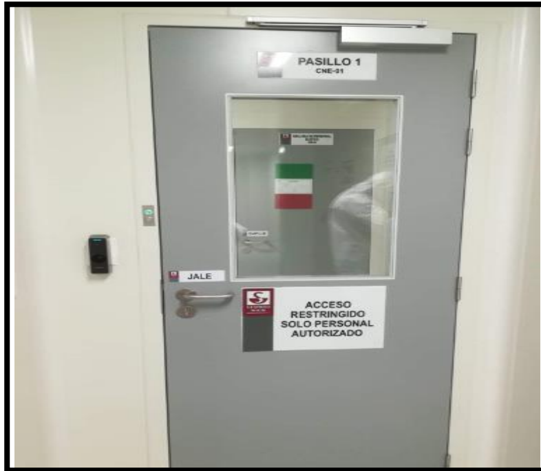
Figura 12. Instalación física del equipo biométrico con lector de huella digital
