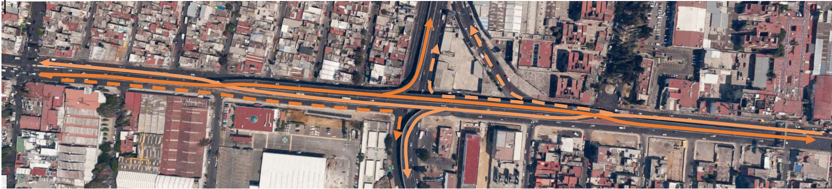
GM.3 Dirección de los flujos vehiculares de Calzada Ermita Iztapalapa Eje 8 Sur en la intersección con Eje 3 Oriente, donde cambia la configuración de CEIE8S como un distribuidor vial elevado. Imagen Satelital adquirida en el sistema en línea Google Maps 2016. Elaboración: JFHP.
