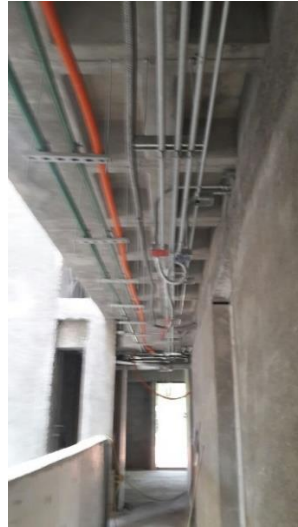
Figura.20 Muestra condiciones de la obra. Nivel 1. Elaboración propia.
