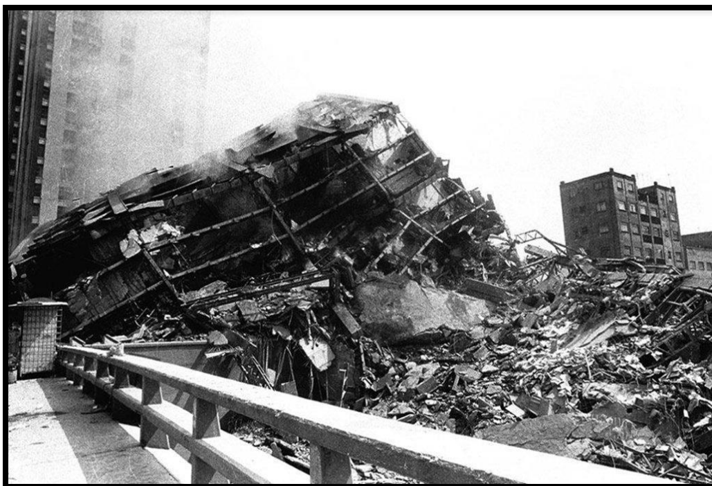
Figura 9. Edificio Conjunto Pino Suárez en el temblor del año 1985
