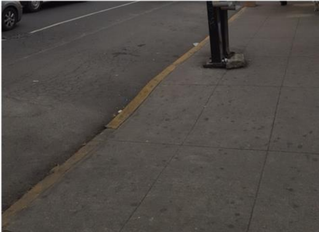
Fotografía 1.7 Condición actual de la intersección Av. Insurgentes Norte - Av. Montevideo.
