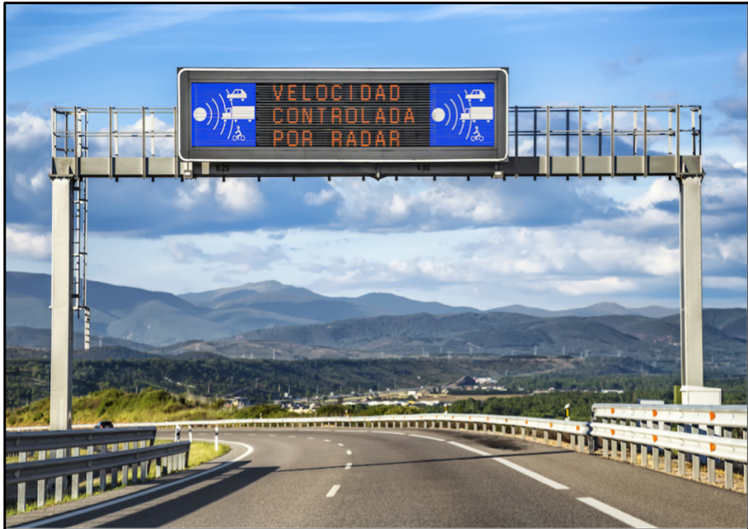
Figura 12 Panel de Mensajería Variable Nota: Reproducida de Panel de Mensajería Variable, de autopistas.com, 2021
