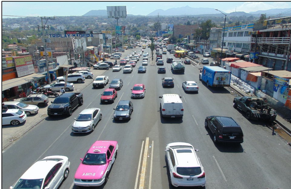
Figura 21 Carriles por Sentido, Carretera Picacho Ajusco Fuente: Elaboración propia, fotografía tomada en la Ctra. Picacho Ajusco intersección Tizimín.
