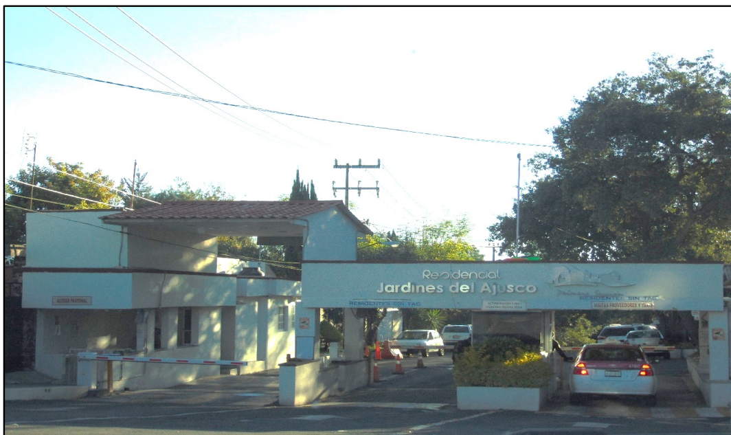
Figura 40 Calle Cerrada, con Plumas y Cacetas de Vigilancia Fuente: Elaboración propia, fotografía capturada en calle aledaña a la Ctra. Picacho Ajusco.
