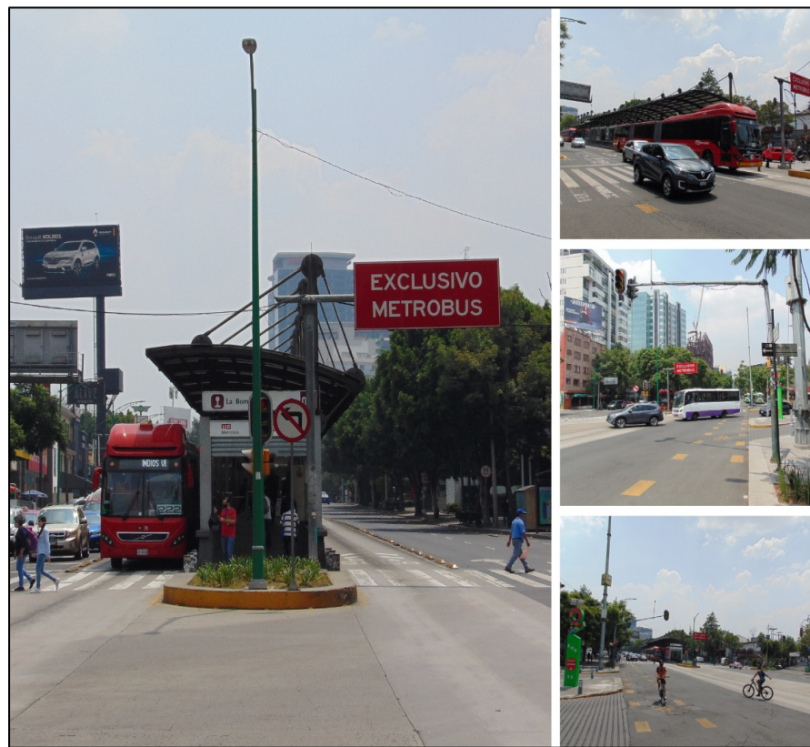
Figura 7 Derecho de Vía Tipo B Fuente: Elaboración propia, fotografía capturada en Av. De los Insurgentes Sur, CDMX.
