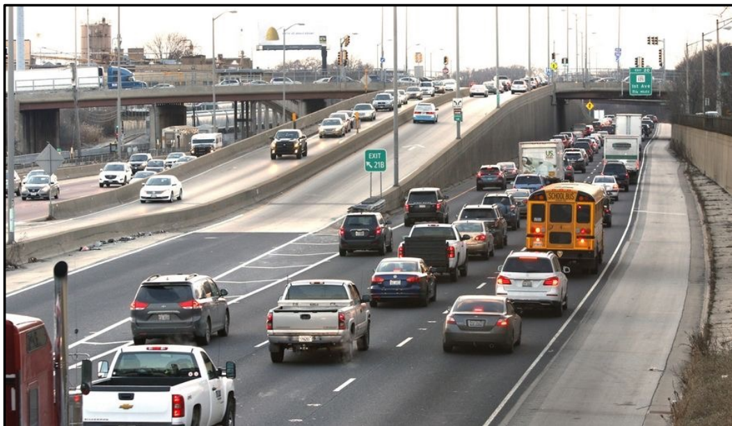
Figura 13 Gestión de Rampas en la Autopista Eisenhower Expressway Chicago Nota: Reproducida de gestión de rampas en la autopista Eisenhower Expressway Chicago, Daily Herald, 2020.
