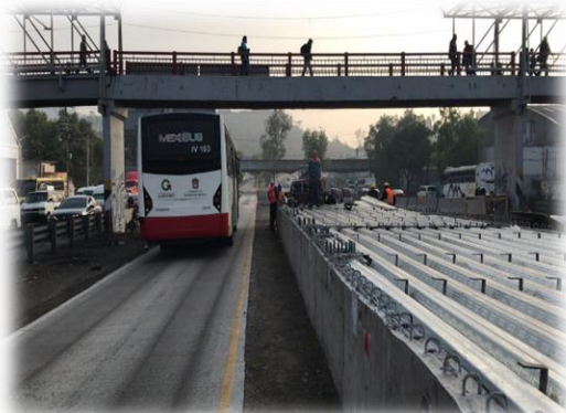
Figura 273. Trabajos sobre carril confinado. Fuente: fotografía de Peralta Rivera Jesús Daniel
