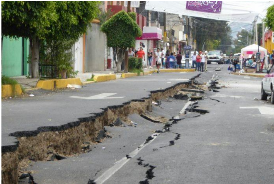
Imagen 9. Agrietamiento en colonia aledaña al cerro del Peñón de Marques en Iztapalapa. Tomado de VITA.ORG
