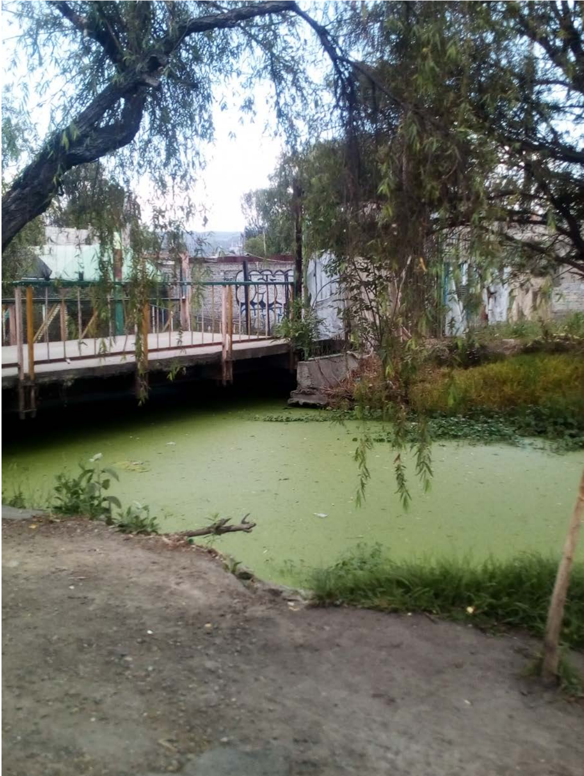
Acumulación de lirio acuático en el interior del canal de Av. Nuevo león. Foto tomada en Abril de 2019.
