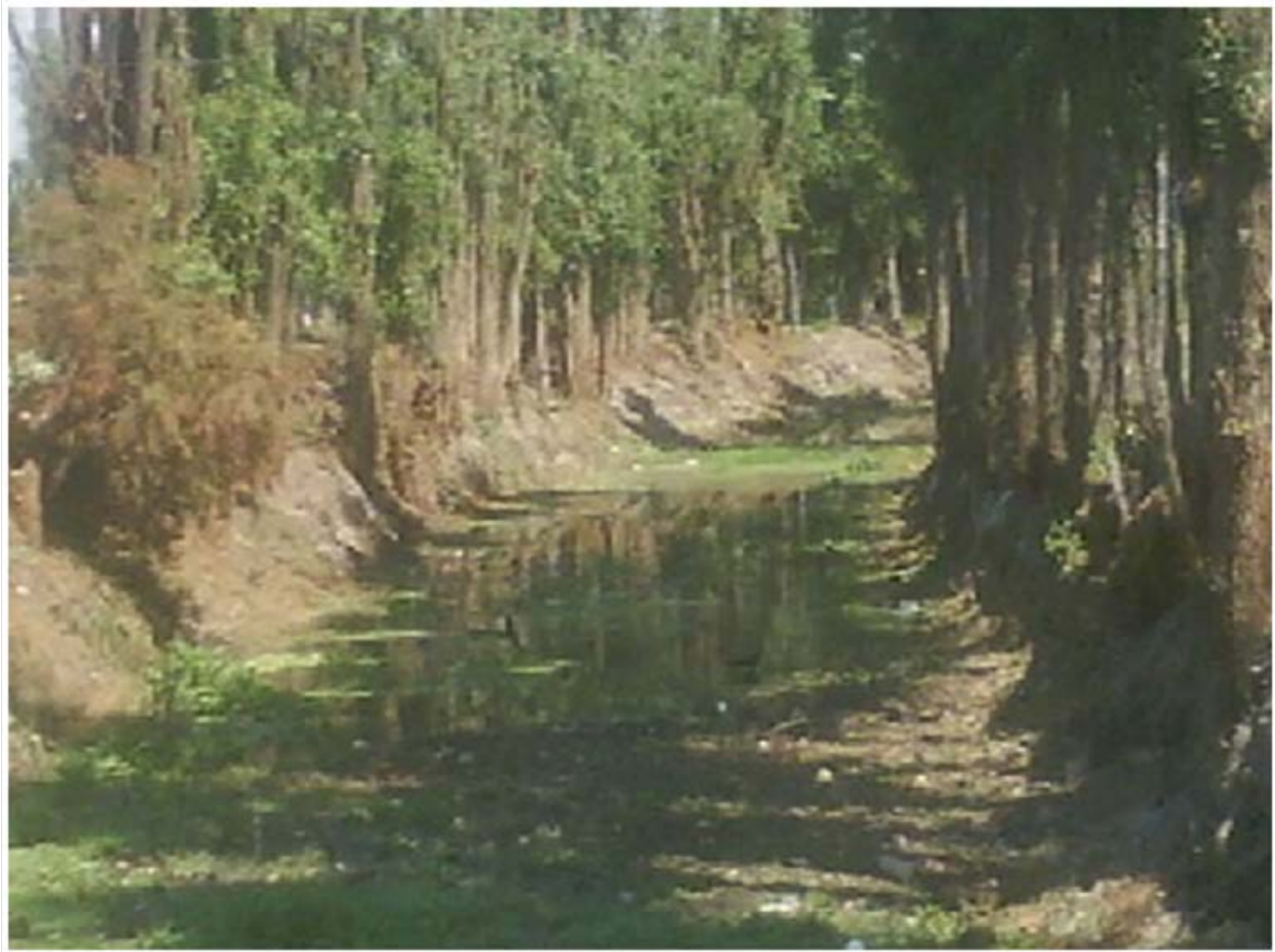
Canal casi seco. Foto tomada en Agosto de 2018.
