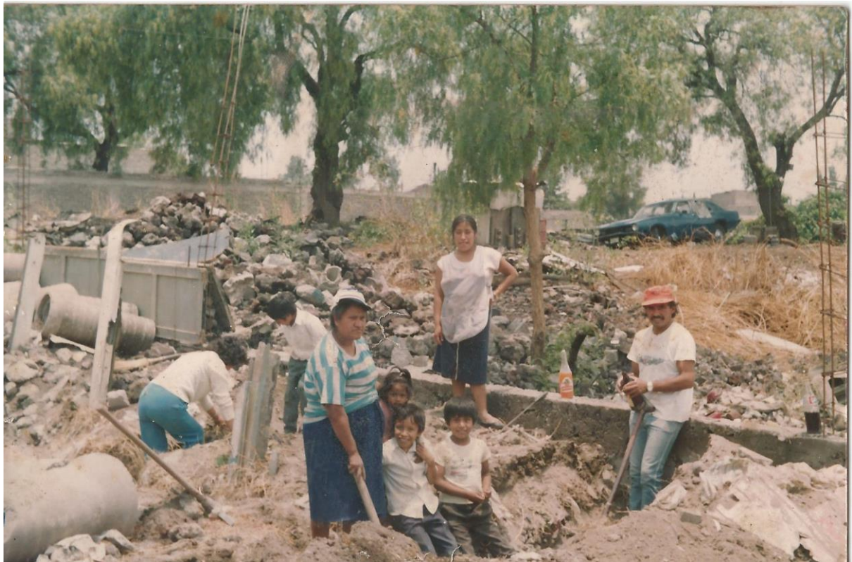
Cuando abrimos la calle para colocar el drenaje. Eva Jiménez.
