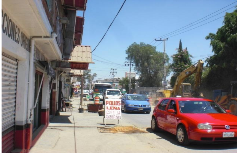
Figura 4.25. Obras en Av. San Lorenzo. [1]
