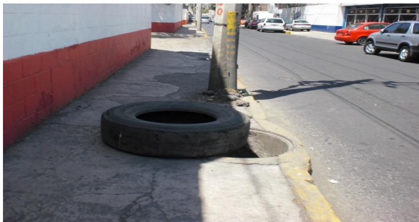
Figura 4.31. Falta de coladeras en calle Lebrija. [1]
