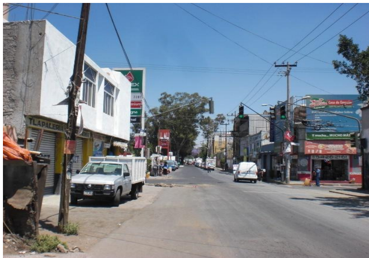
Figura 4.27. Obras en Av. San Lorenzo. [1]
