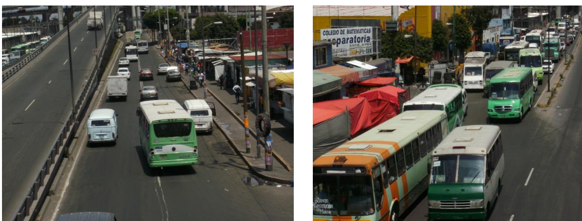
Figuras 4. 7. Distribuidor Vial Zaragoza - Texcoco
