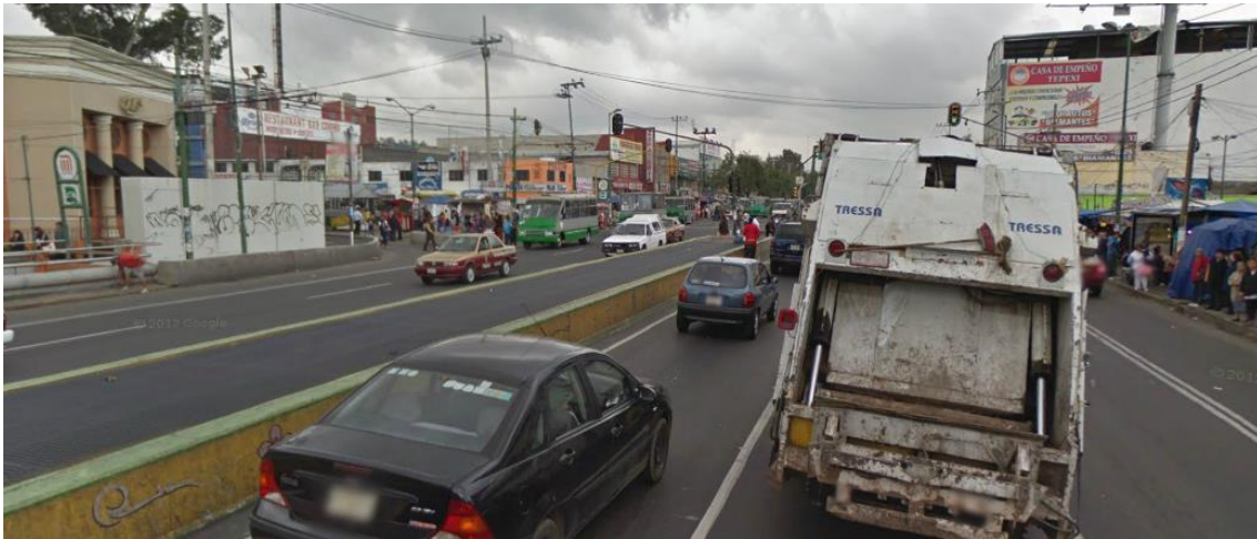
Figura 4. 11. Infraestructura de la estación de Metro UAM
