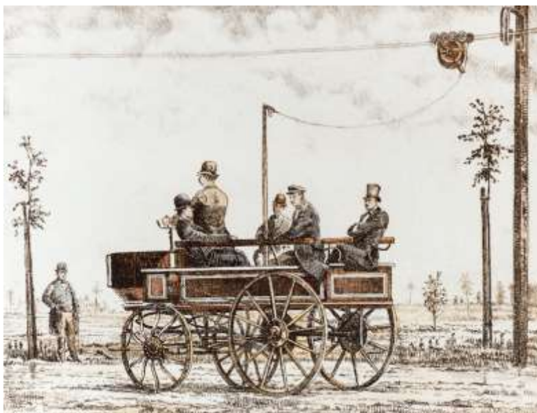
Figura 2. Elektromote: Primer vehículo eléctrico alimentado por vía aérea o catenaria.
