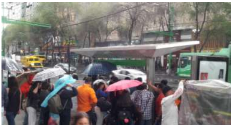
Figura 24. Parada Madero, deficiencias para alojar a los usuarios.
