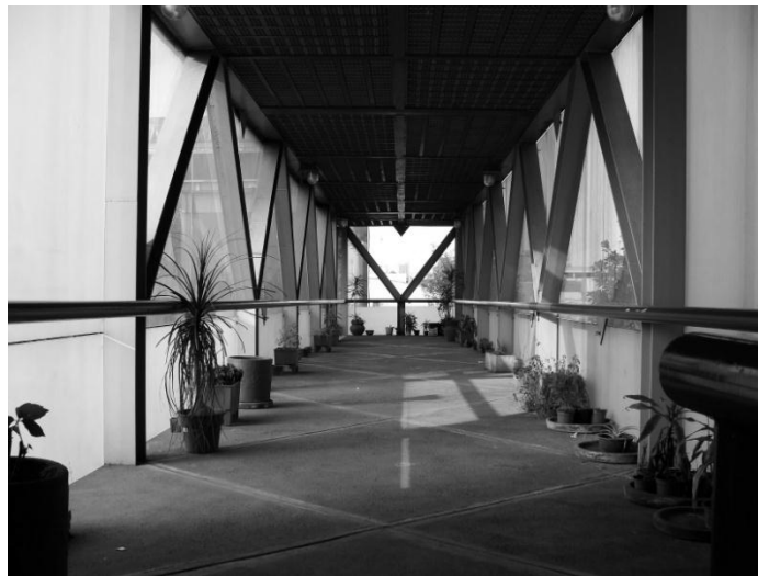
Puente de enlace entre los edificios de Plantel Centro Histórico
