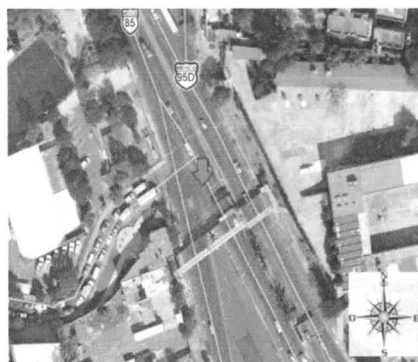
Figura 3.50 Estación 11 Insurgentes Calzada de Tlalpan - Carretera Federal a Cuernavaca
