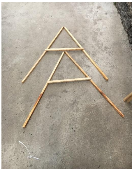
Figura 69. Construcción del invernadero.
